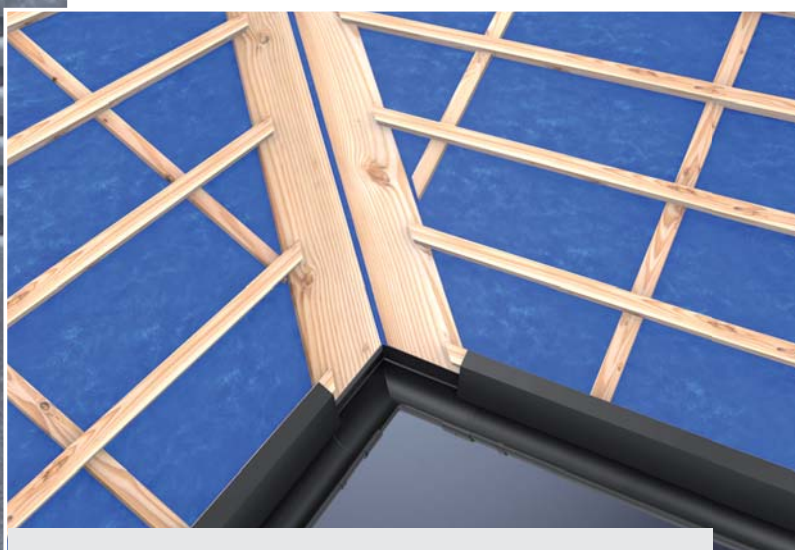
Příprava pod úžlabním plechem.
