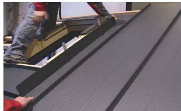
Zhotovení čelového oplechování z hladkého plechu a jeho přichycení k větracím profilům a oknu. Osazení druhé boční šablony, vytvarované do potřebného tvaru.
