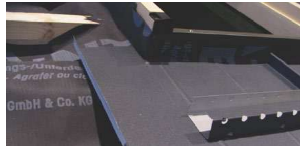
Osazení spodních šablon upravených do potřebného tvaru.
