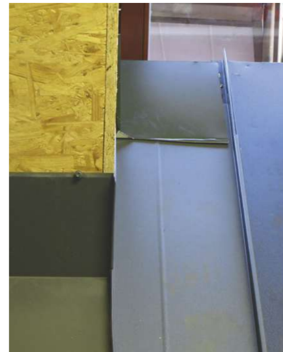
Obr. g, h – Osazení zadního oplechování vytvořeného z hladkého plechu.
