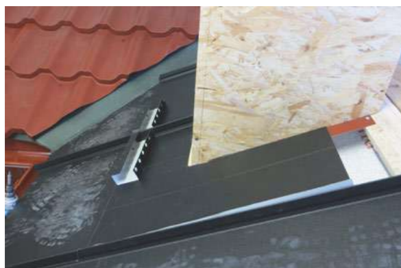
Obr. c – Po odstříhnutí vnější strany zámků první šablony v místě příčného přeložení s druhou šablonou se šablona uchytí nerezovými šrouby a osadí se větrací profily.
