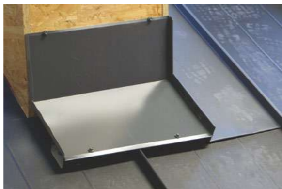
Obr. e – Osazení čelního oplechování z hladkého plechu a jeho uchycení k větracím profilům a zafalcování k druhé šabloně.
