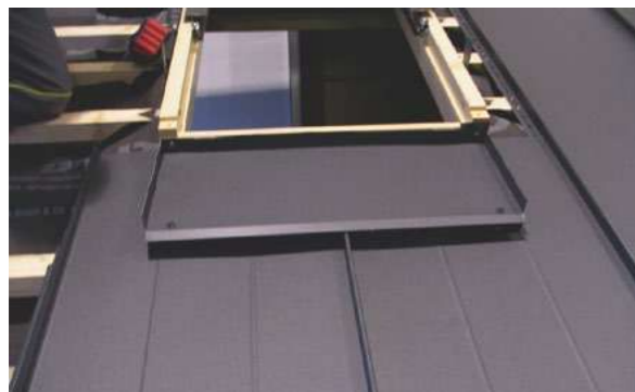
Zhotovení čelového oplechování z hladkého plechu a jeho přichycení k větracím profilům a oknu. Osazení druhé boční šablony, vytvarované do potřebného tvaru.
