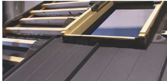
Osazení spodních šablon upravených do potřebného tvaru.
