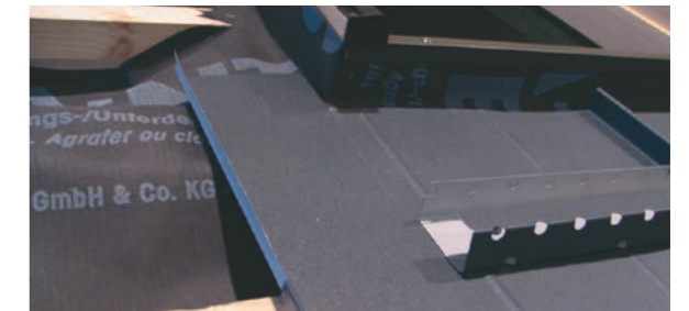
Osazení spodních šablon upravených do potřebného tvaru.
