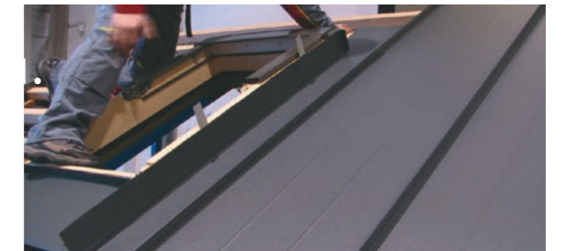
Zhotovení čelového oplechování z hladkého plechu a jeho přichycení k větracím profilům a oknu. Osazení boční šablony, vytvarované do potřebného tvaru.
