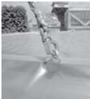
Zavěsit zvedací lano – hák na kolektor
