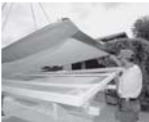
Sejmout dřevěnou konstrukci z kolektoru
