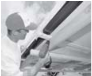
Odmontovat dřevěnou konstrukci z kolektoru
