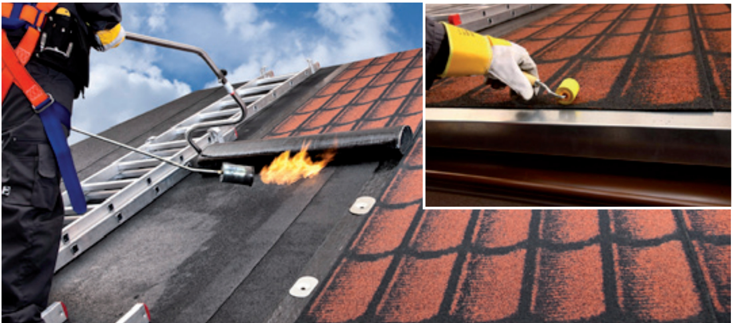
Natavování pásu RDI 3D® na šikmou střechu.
