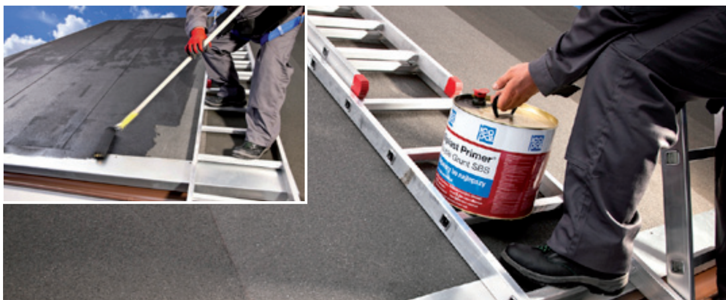
Penetrace starého podkladu asfaltovým SBS modifikovaným nátěrem Siplast Primer.
