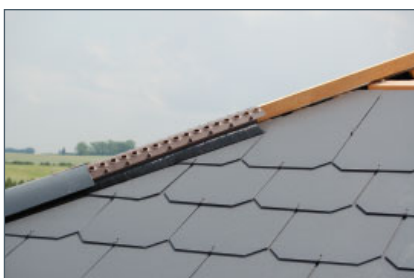
Velikost výstupního otvoru při větrání hřebenem je 100 cm 2 /bm. Větrací mezera 1 cm/bm.
