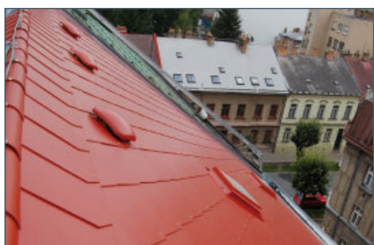
Větrání střešního pláště je realizováno plastovými hlaviciemi.
